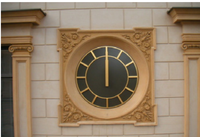
Hyvin toteutettu kello korostaa julkisivun ulkonäköä.
